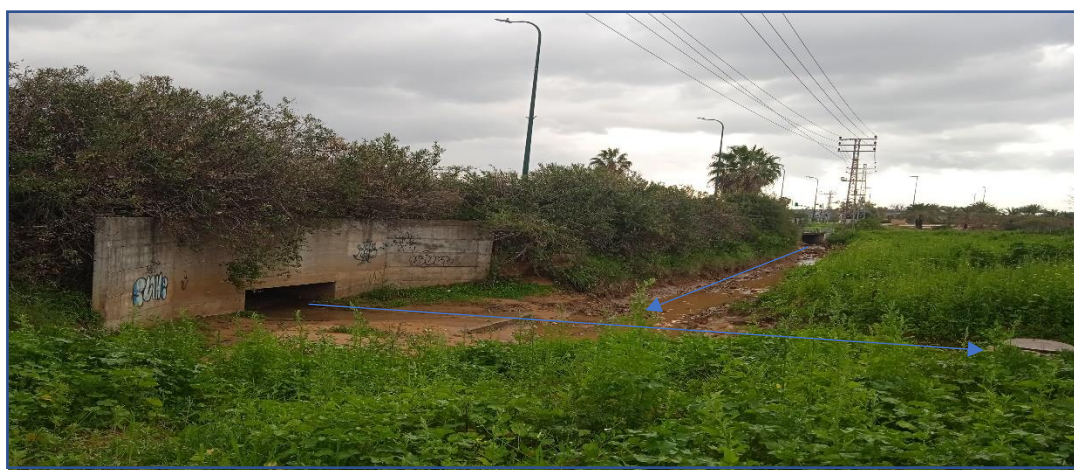
תמונה 6.2 – מוצא מערכת התיעול העירונית לכיוון נחל נס ציונה (עם כיווני הזרימה לנחל)
