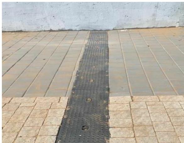
תרשים 9.5 – תעלת הניקוז הרדודה מימין – סרטוט סכמתי, ומשמאל התקנה בשטח.
